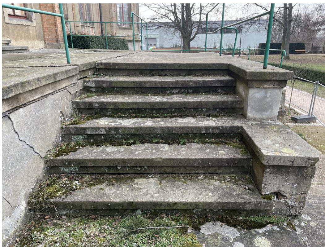
Pravé křídlo nástupního schodiště na terasu
