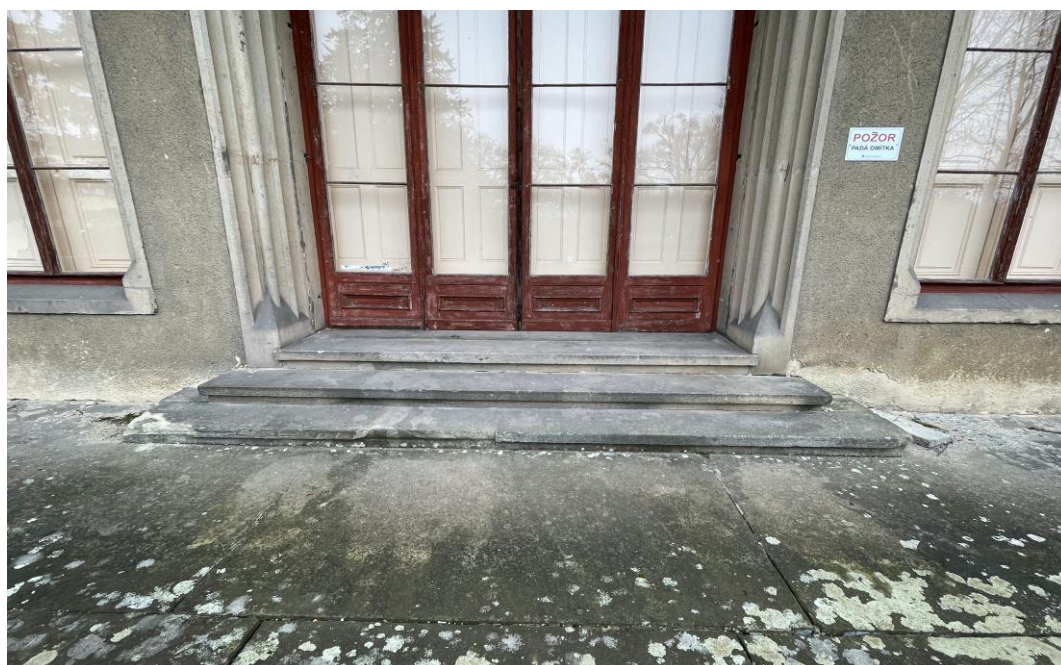
Detail soklu pylonu nároží rizalitu a vstupních schodů z terasy do zámku - západní průčelí
