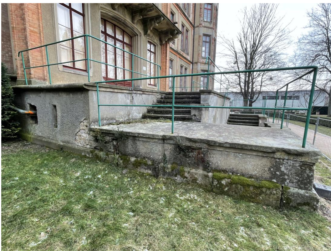
Levé křídlo nástupního schodiště na terasu
