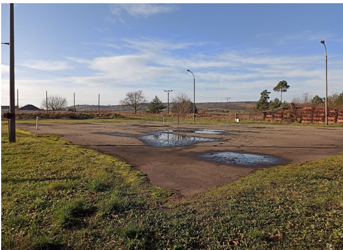
ASFALTOVÉ HŘIŠTĚ Za Humny
