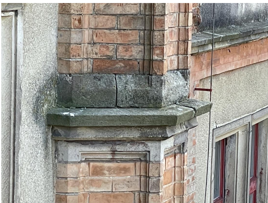
Detaily průběžné korodonové římsy Z/13 a Z/14 probíhající přes postranní pylony rizalitu západního průčelí
