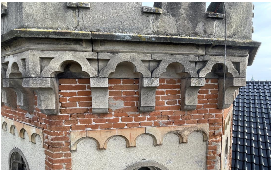
Detaily vrcholového cimbuří SZ/1 a keramického obloučkového vlysu SZ/2 SZ věže
