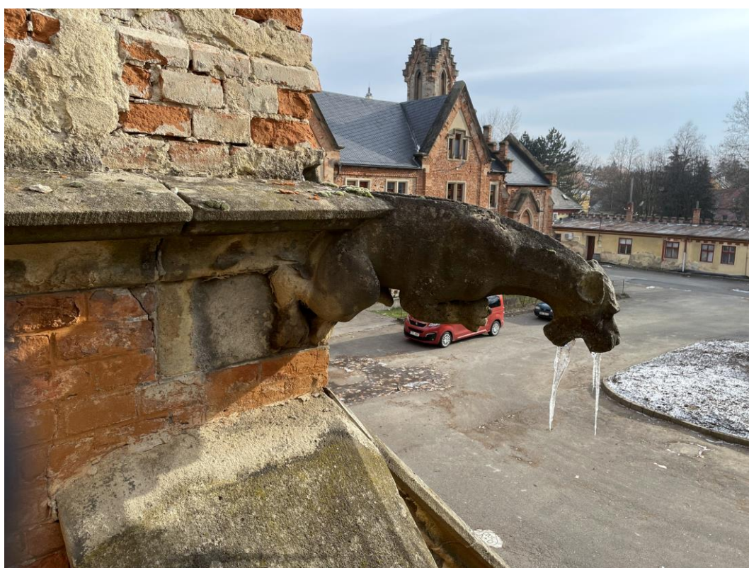
Detaily chrliče V/55 a kružbového pásu V/49 a balustrády V/48 síně východního průčelí
