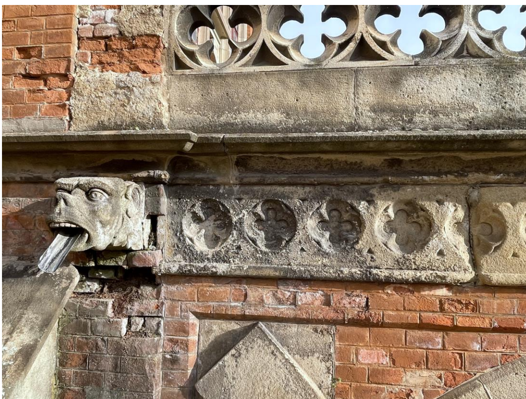
Detaily chrliče V/54 a kružbového pásu V/49 síně východního průčelí
