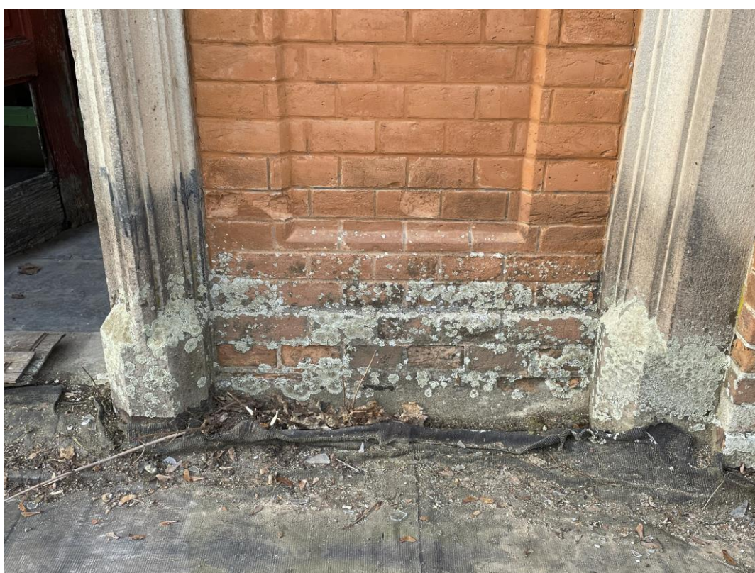
Detaily kamenného ostění V/21 a lícového cihelného zdiva ve styku s terasou
