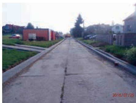
úpravy komunikace Pod Kněží horou
