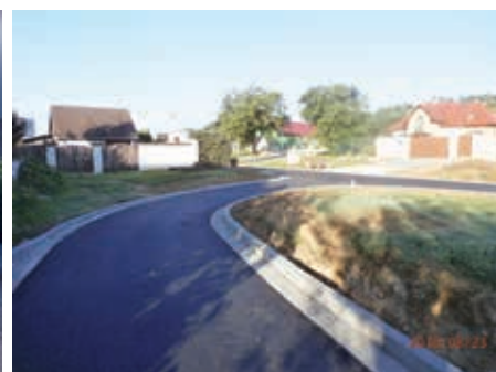
úpravy komunikace Pod Kněží horou
