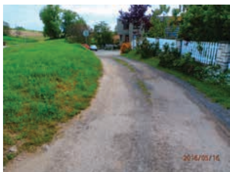
úpravy komunikace Pod Kněží horou
