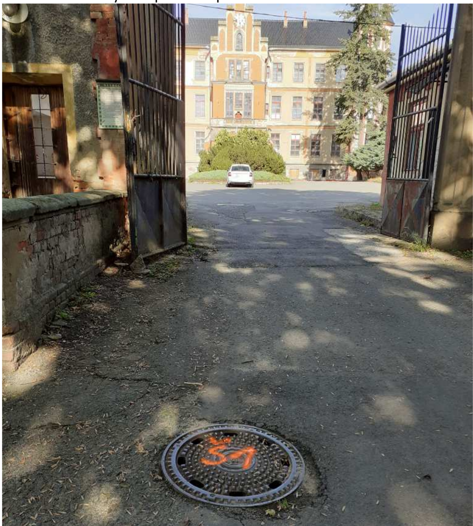
Fotodokumentace hlavní šachty Š1 – před vstupní bránou do zámku:
