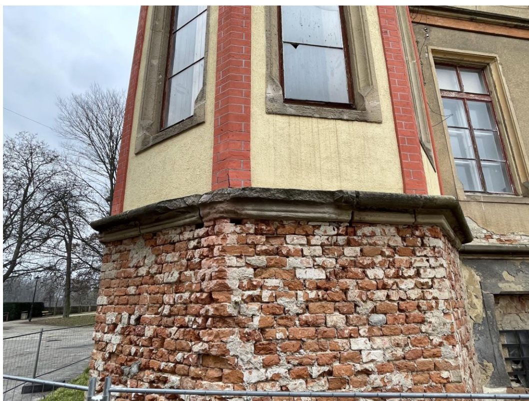
Soklová část JV věže s průběžnou římsou soklu JV/21 a trnoží soklu JV/23
